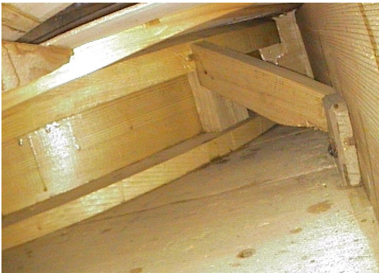
Abb.7: Endoskop-Aufnahme, Innenkonstruktion des Korpus.
