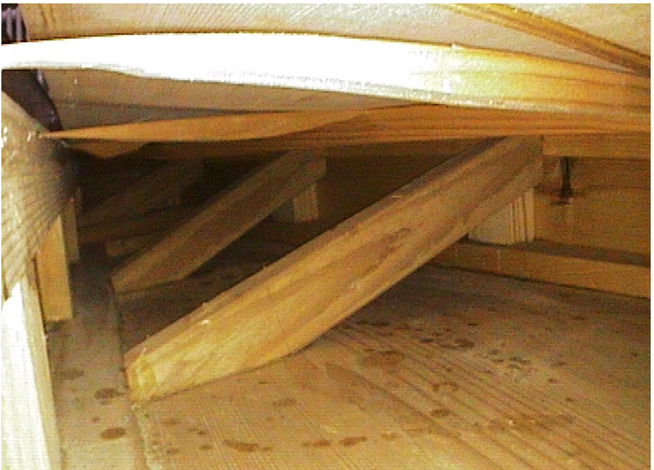
Abb.6: Endoskop-Aufnahme, Innenkonstruktion des Korpus.
