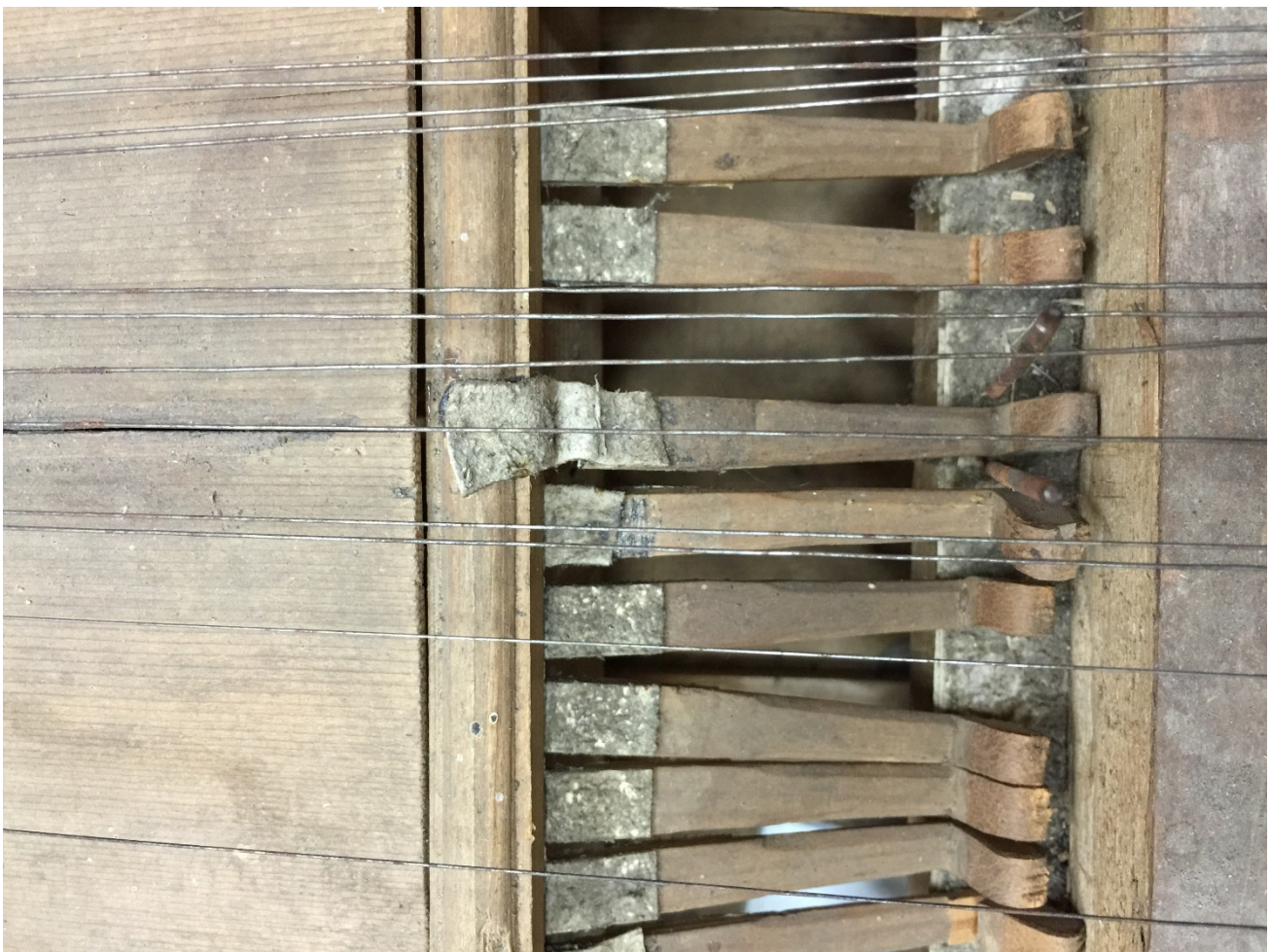
Abb.18: Detail Hammerleiste: Provisorisch mit einem Schaflederstreifen an der Anhängeleiste befestigter Hammer.
